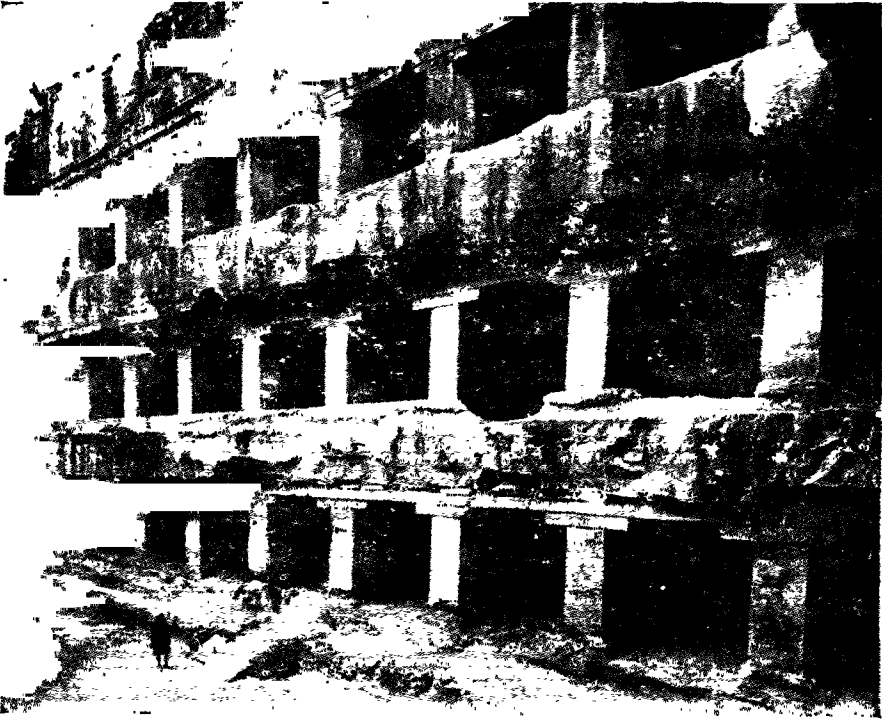
Fig. 13. Ellora, Tin Thal cave: Façade
