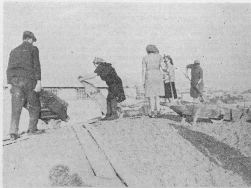
Među prvim graditeljima Novog Beograda bilo je puno devojaka ali, radile su sve, pa i najteže poslove
